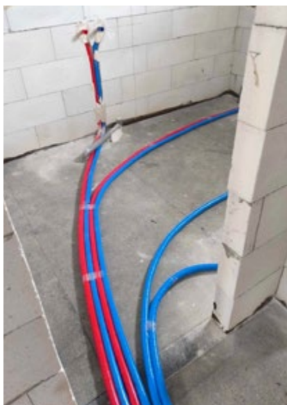
Ručně tvarovaný oblouk pomocí ohýbací pružiny
